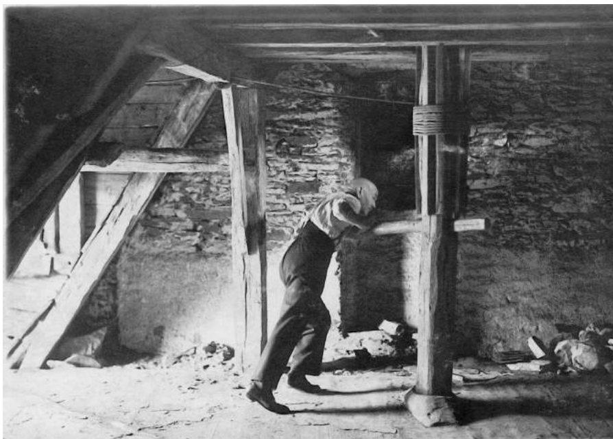
Göpelwerke waren im Mittelalter keine Besonderheit. Vor allem bei Haus- speichern, wie hier auf dem Dachboden des 1490 errichteten Gebäudeflügels auf Schloss Bürresheim besaßen einen Göpel.
