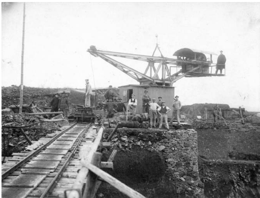
1904 errichtete der Mayener Grubenbesitzer Caspar Helmes den ersten mit elektrischem Strom angetriebenen Grubenkran aus Stahl.
